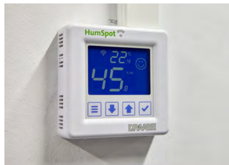
Digitale Steuergeräte regeln die Luftfeuchte auf mindestens 40 Prozent.
